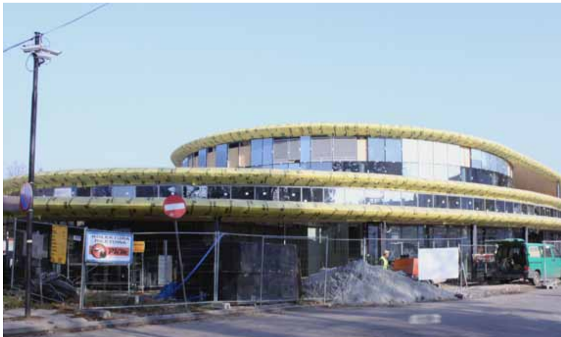
W budynku zamontowano już szyby. Trwają prace wykończeniowe.
